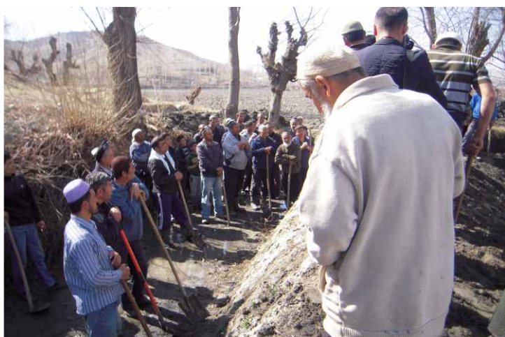
Совместная очистка канала, р. Исфара, 2016 г.
