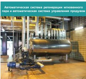
Автоматическая система регенерации мгновенного пара и автоматическая система управления продувом
