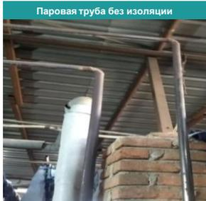
Паровая труба без изоляции
